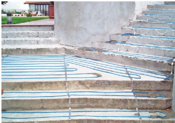
Расположение нагревательных кабелей
