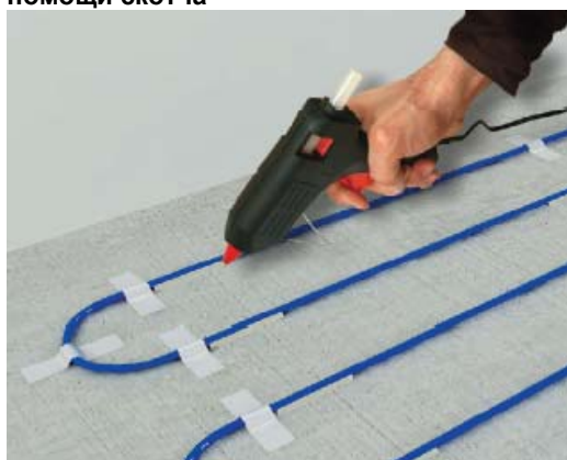
Установка нагревательного кабеля ELEKTRA DM горячим клеем.
