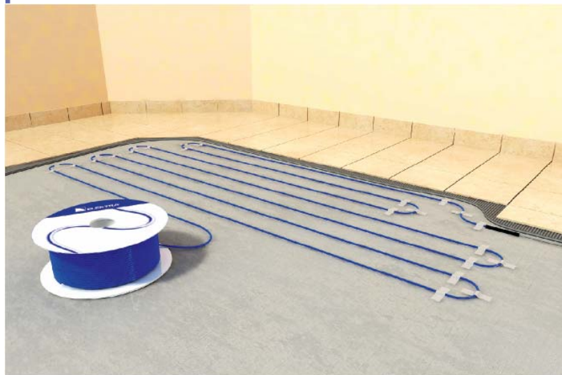
Установка нагревательного кабеля DM должна производиться при помощи скотча
